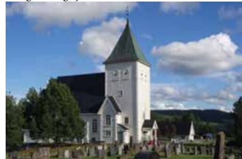
Frogner kirke er en vakker bygning og ligger synlig til i terrenget. Og selv om den nå er 101 år, kan vi fortsatt kalle den for nykirka.
