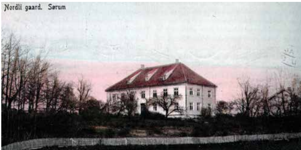
Den store hovedbygningen på Nordli ble valgt for å arrangere møte om kanalbygging i 1848. Foto: Sørum fotosamling
